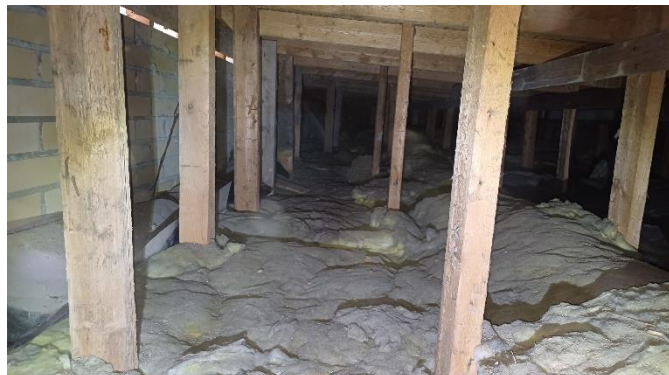
Kuva 2 Yleiskuva yläpohjatila, ulkoseinän vierusta
