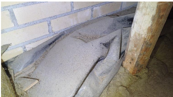
Kuva 5 Ulkoseinän vierustalla muovikalvo lämmöneristekerroksen päällä
